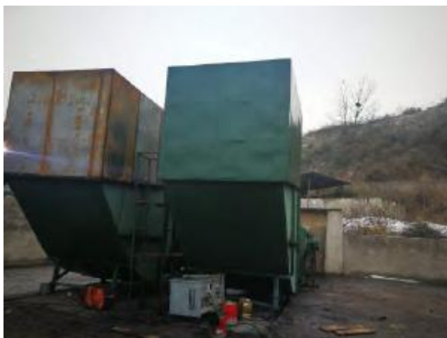
风井口消音设备改造照片
